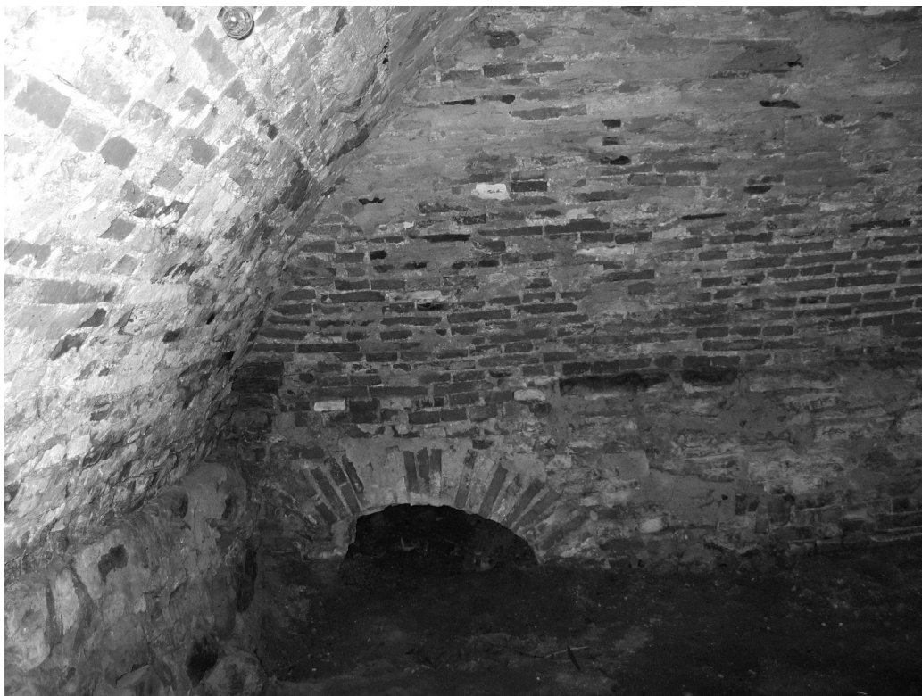
Ил. 4. Арочный проход для грунтовых вод в подвале Владычной палаты. XV в.
